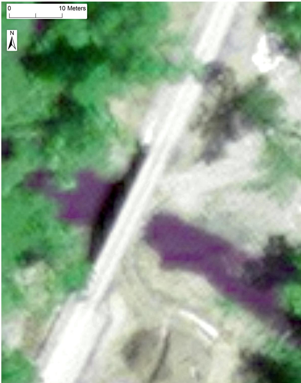
Figura 11. Ponte metallico sul rio Pindoyacu all'interno del Parco Nazionale Yasuní.
